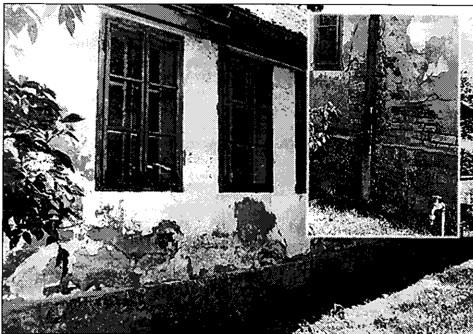
A dolgos kezek munkájára váró decsi plébánia épülete. Következő számunkban bemutatjuk a felújított épületet is.
